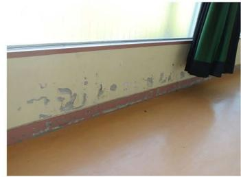
内壁：塗装の剥離、剥落
