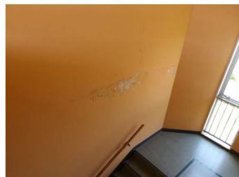
内壁：塗装の剥離、剥落
