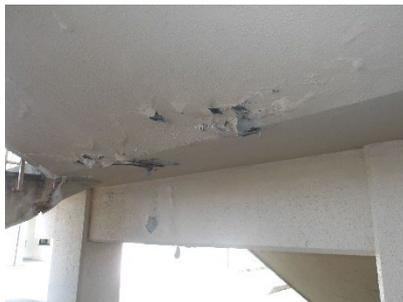
昇降口階段：塗装の剥離、剥落
