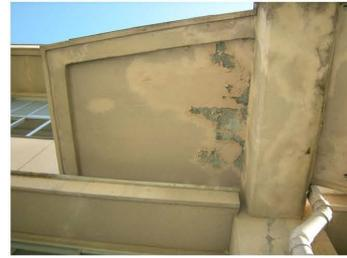
軒裏：塗装の剥離、漏水痕
