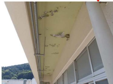
軒裏：塗装の剥離、剥落
