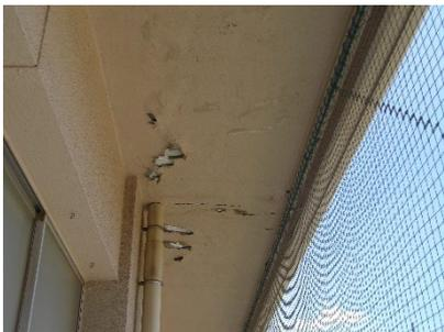
軒裏：塗装の剥離、剥落
