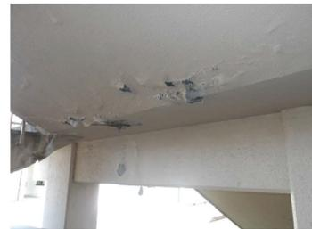
階段裏：塗装の剥離、剥落
