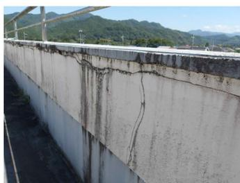
パラペットのき裂、損傷
