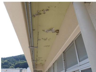
軒裏：塗装の剥離、剥落
