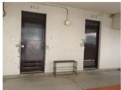
外壁：塗装の剥落
