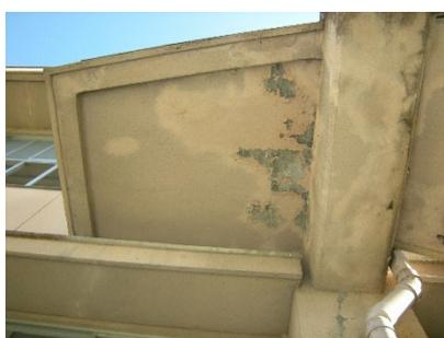
軒裏：塗装の剥離、漏水痕
