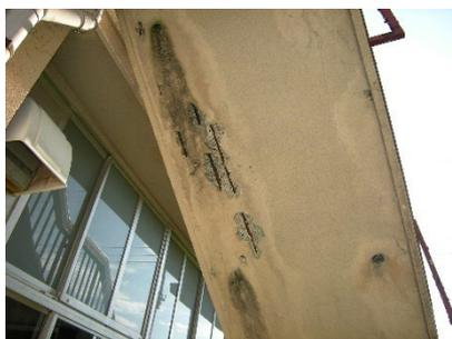
外階段：鉄筋の露出、漏水痕
