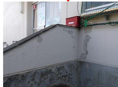
塗装の剥離、剥落
