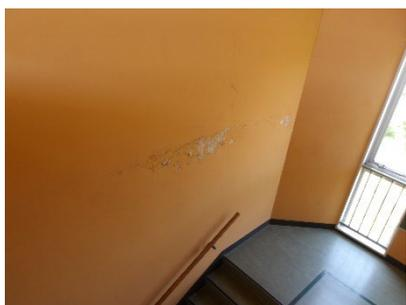
階段室：内壁のはく離、剥落
