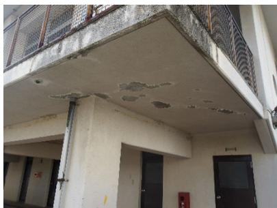
軒裏：漏水痕、塗装の剥離等
