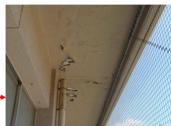
軒裏：塗装の剥離、剥落
