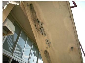
階段裏：鉄筋の露出、漏水痕
