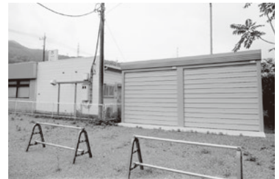
新設された消防自動車の車庫
