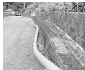
むき出しの水道管
