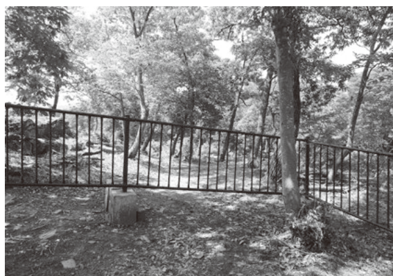
転落防止柵も復旧された
